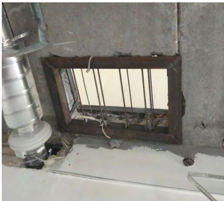
Рисунок 2 – Общий вид обследуемой плиты, с технологическим отверстием
