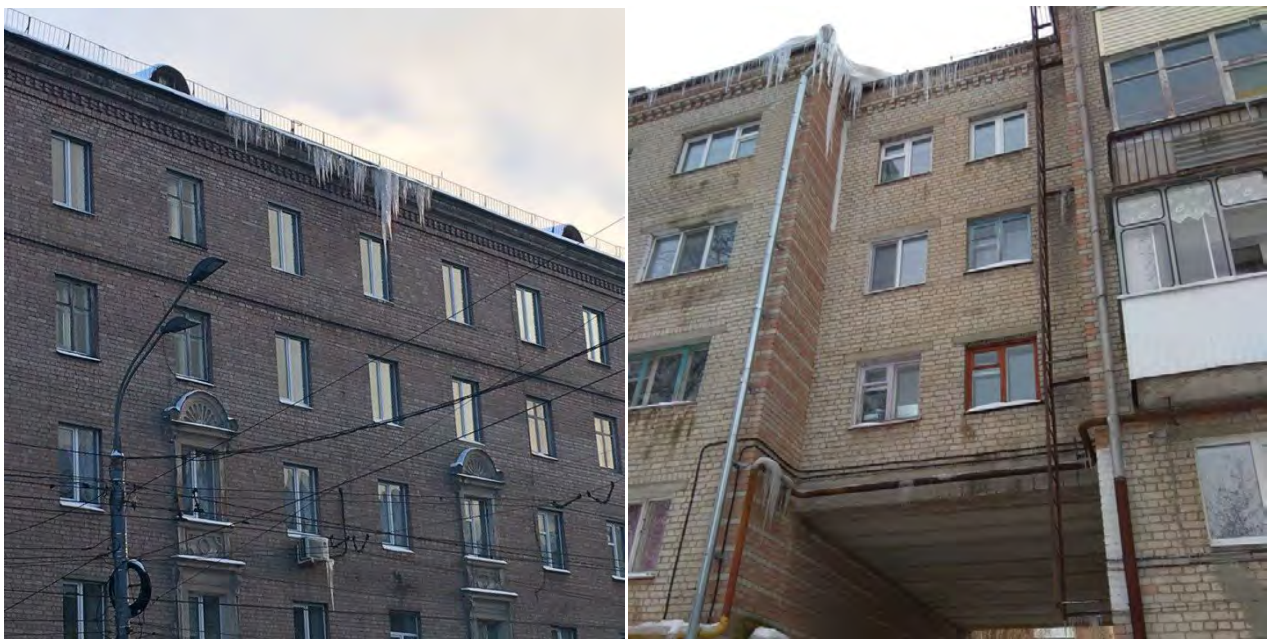
Рисунок 1 – Примеры обледенения кровли в г. Брянск
