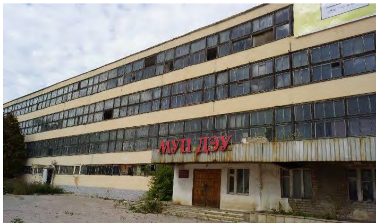
Рисунок 1 – Общий вид здания со стороны главного фасада
