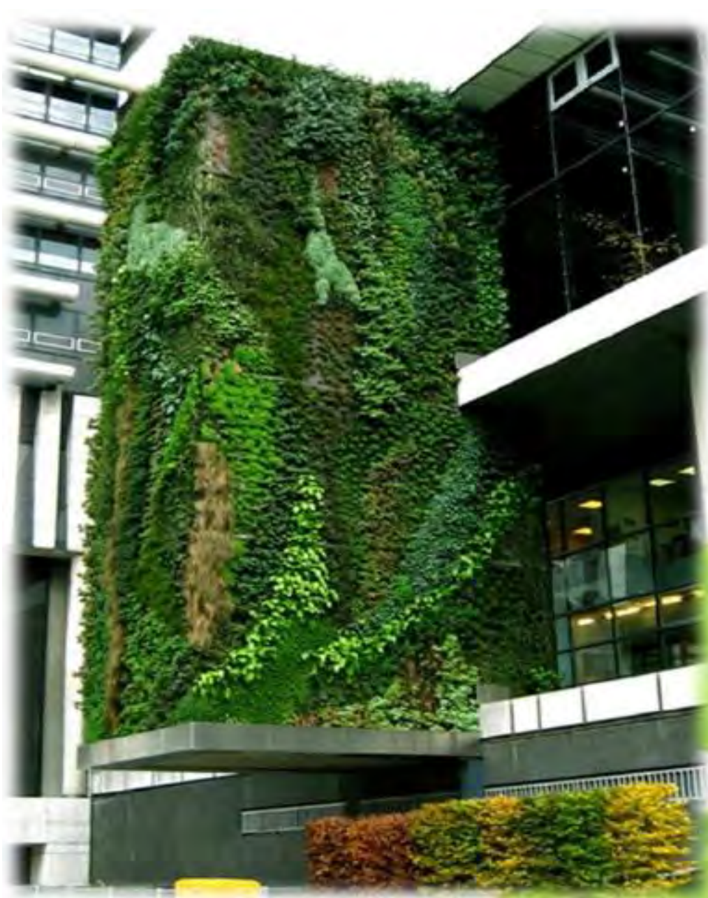
Рисунок 1 – Вертикальное озеленение здания Hotel Department Hauts
