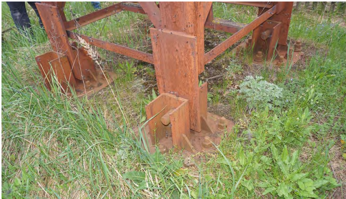
Рисунок 2 – Узел крепления вышки к фундаменту
