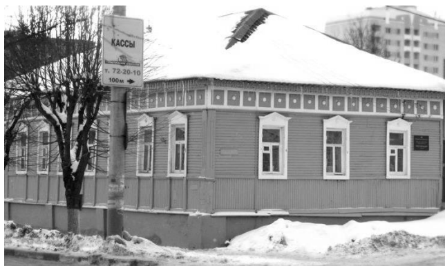
Рисунок 1 – Фото объекта до пожара - 2011 г.
