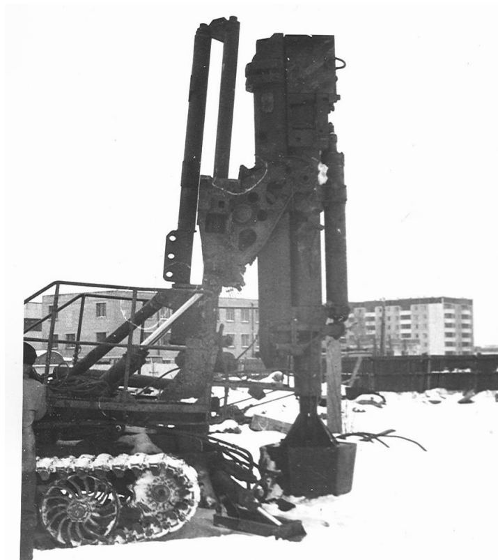
Рисунок 4 – Установка УЗАС-2 с застреливаемым в грунт штампом
